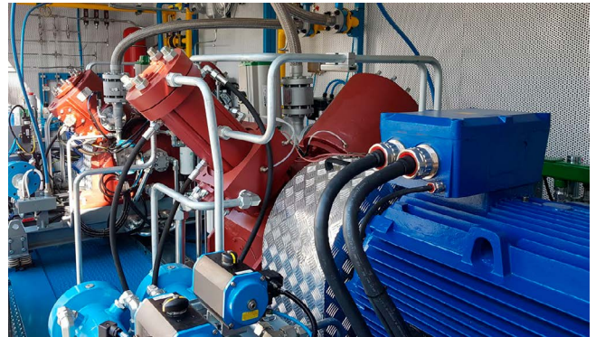
Instalación de compresores en tándem con sistemas de control
